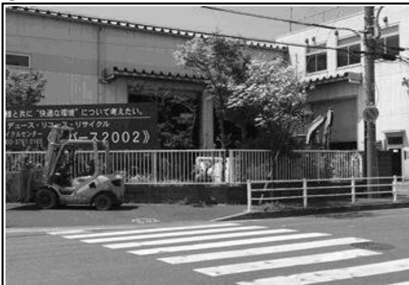
①施設の外観(施設名称:第一工場)
