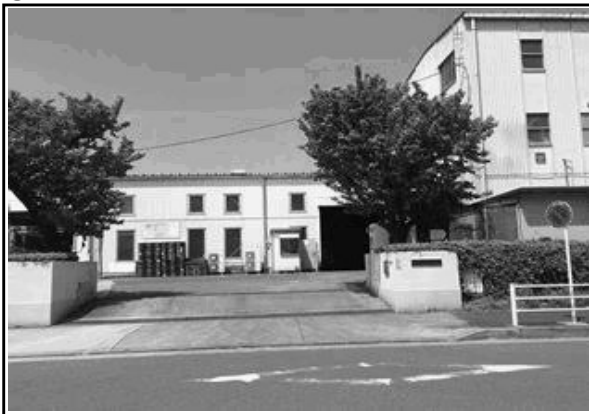
処分を行う事業場(その2)における施設の現況 ①施設の外觀(施設名称:第二工場)
