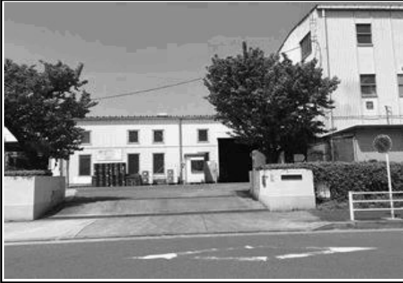
処分を行う事業場(その2)における施設の現況 ①施設の外觀(施設名称:第二工場)
